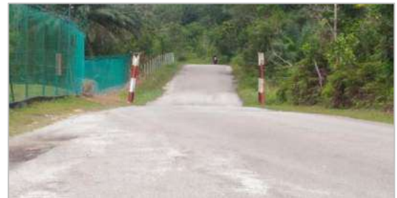
Gantry gate yang terletak sebelum kawasan empangan dari arah Felda Cahaya Baru Masai
