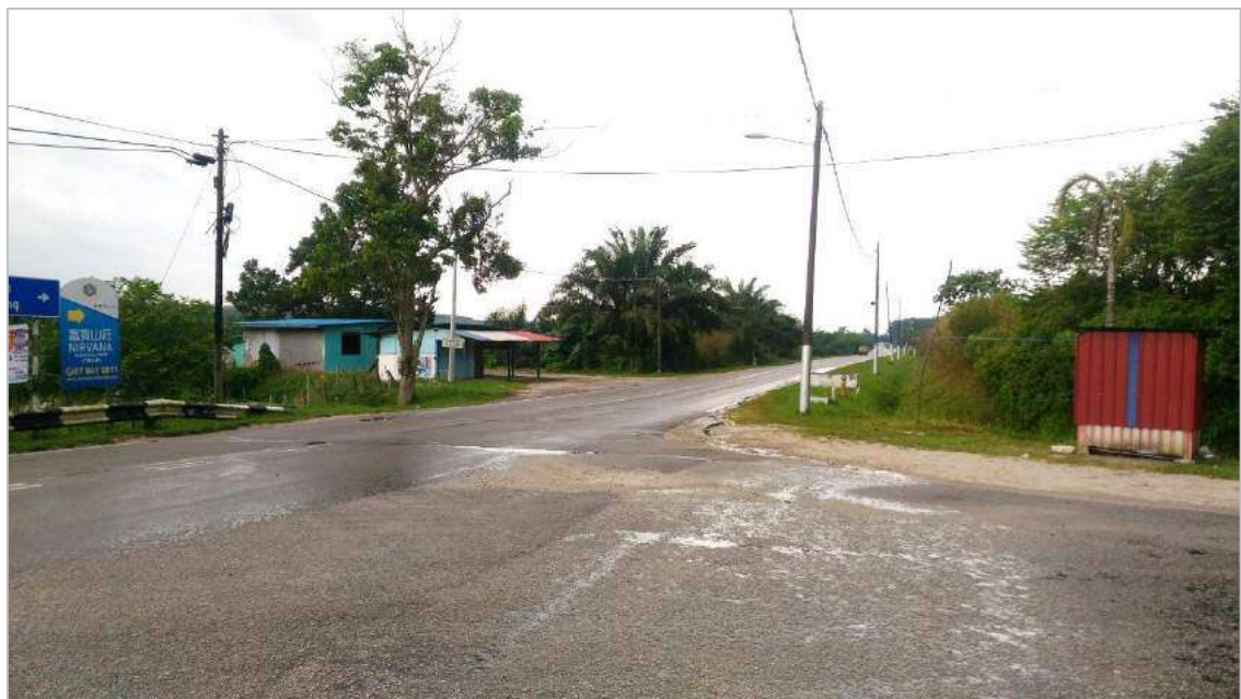
Tiada lorong percepatan dan perlambatan yang di sediakan di Persimpangan 3 Kawalan Berhenti Jalan Sg. Tiram (J8) / Jalan Felda Sg. Tiram
