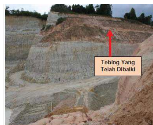
Cerun yang telah dibaiki dengan kaedah slopping
