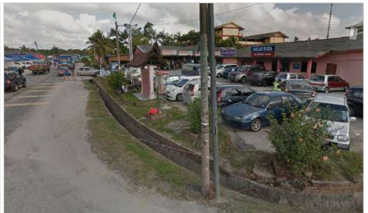
Keadaan longkang sedia ada di jalan Sg. Tiram yang mengurangkan larian air permukaan
