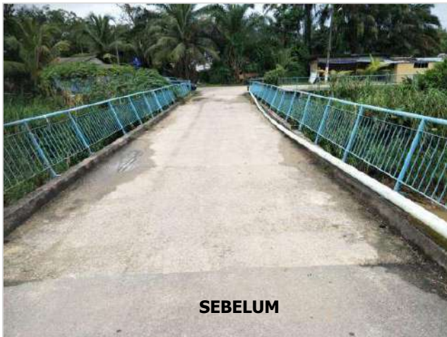
Jambatan Jalan Abdullah
