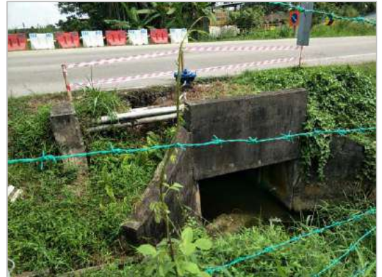
Antara pembetung (culvert) yang terdapat di Jalan Sungai Tiram
