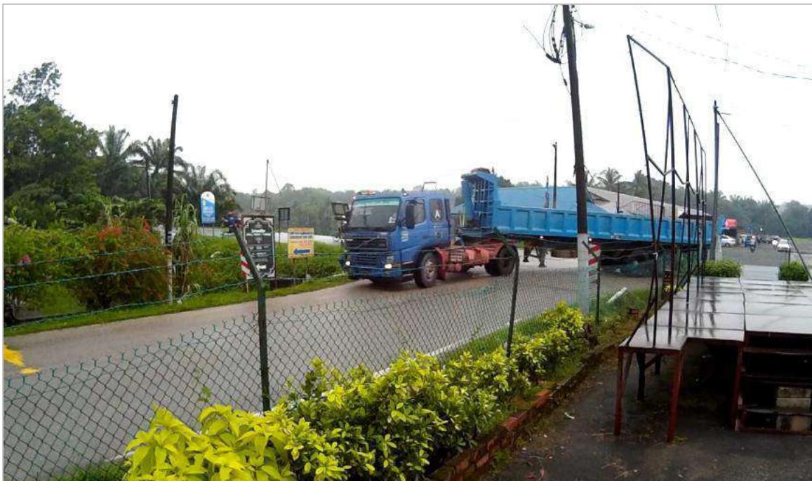
Radius pusingan di persimpangan 3 Kawalan Berhenti Jalan Sg. Tiram (J8) / Jalan Sg. Redan (J11) yang tidak mencukupi untuk kenderaan berat.
