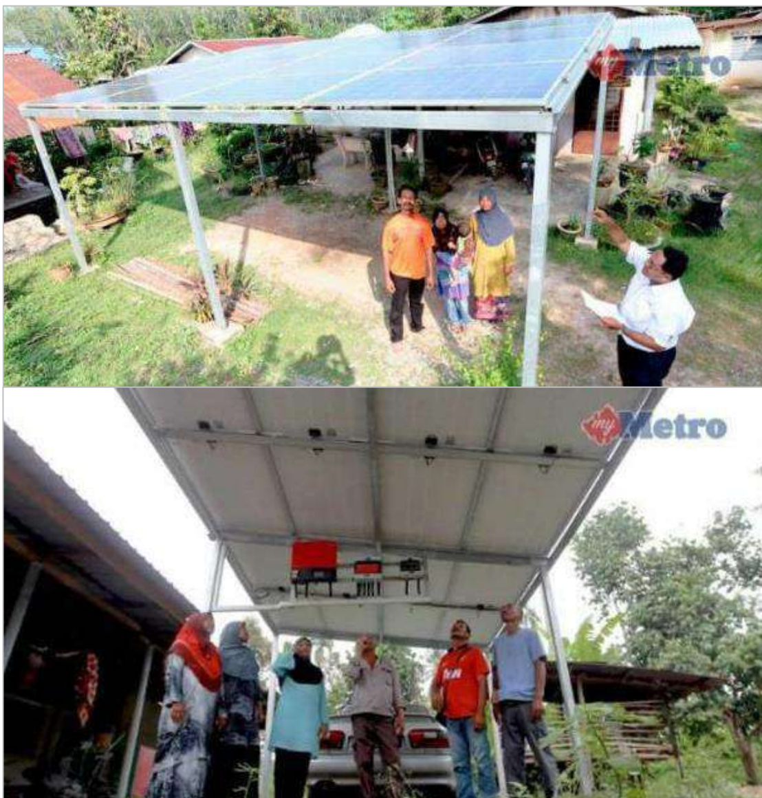
Pemasangan panel solar di Pekan Pauh
