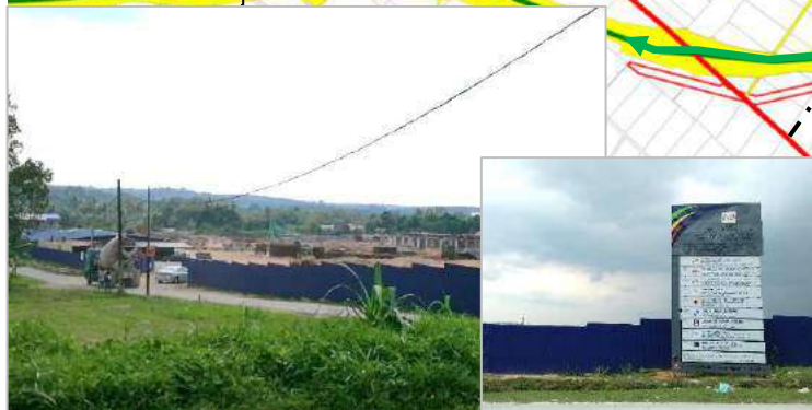
Kawasan cadangan perumahan PPR yang telah berlaku proses kerja tanah
