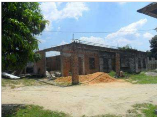
Perumahan berstruktur batu sedang dalam pembinaan
