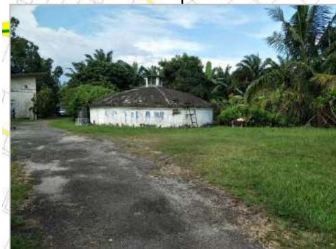
Rumah Pam Jalan Sungai Tiram
