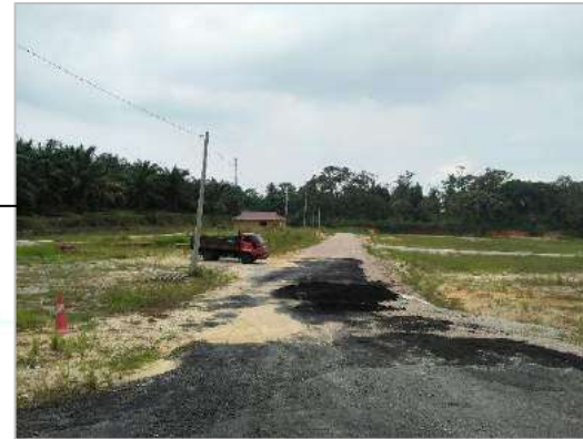
Kawasan cadangan perumahan sesebuah yang telah berlaku proses kerja tanah
