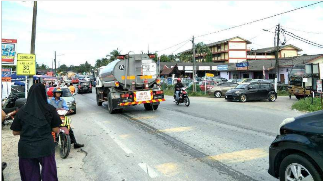
Tiada lorong percepatan dan perlambatan yang di sediakan di Persimpangan 3 Kawalan Berhenti Jalan Sg. Tiram (J8) / Jalan Sg. Redan (J11)
