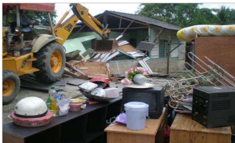
Perobohan setinggian di Kampung Desa Pinggir, Kempas
