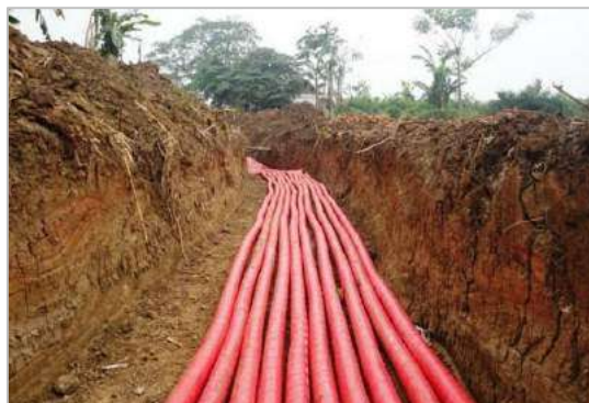
Penanaman Kabel Elektrik bawah tanah yang lebih selamat
