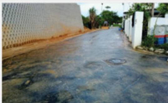
Kerja-kerja membina tembok penahan jenis 'betoflor' di Jalan Lembah 64, Bandar Seri Alam, Pasir Gudang, Johor
