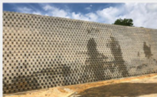
Kerja-kerja membina tembok penahan jenis 'betoflor' di Jalan Lembah 64, Bandar Seri Alam, Pasir Gudang, Johor
