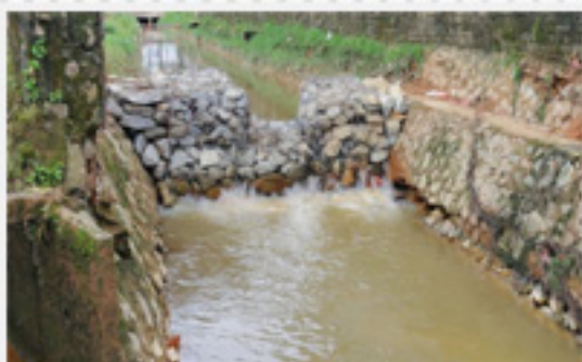
Kerja-kerja menyelenggara dan membersih parit serta kerja-kerja memasang gabion di Jalan Kota Puteri 1, Seri Alam, Pasir Gudang
