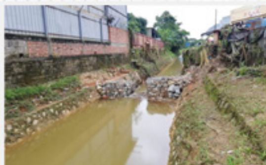
Kerja-kerja menyelenggara dan membersih parit serta kerja-kerja memasang gabion di Jalan Kota Puteri 1, Seri Alam, Pasir Gudang
