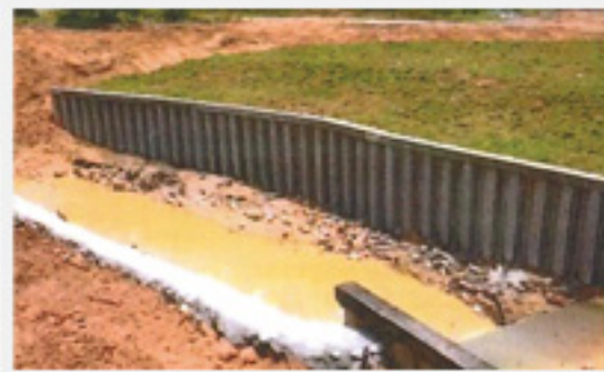
Membaiki cerun runtuh di Kg Sentosa Barat, Dun Tiram, MB Pasir Gudang
