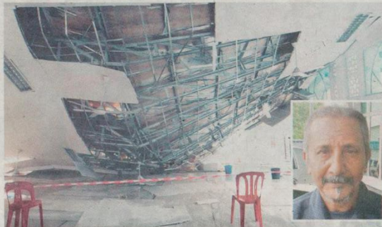
Bumbung bahagian solat tambahan Masjid Taman Rinting yang roboh. Gambar kecil: Mohd Hirman
