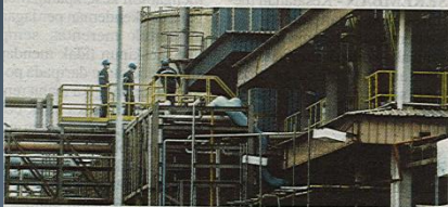
Dalam letupan di sebuah kilang di Tanjung Langsat, Pasir Gudang, Johor pada Sabtu, seorang pekerja maut manakala dua lagi cedera.
